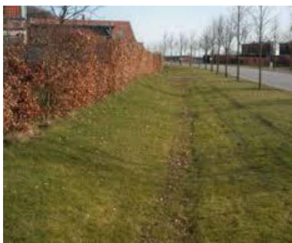
Figur 7: till vänster: Svackdike i Helsingborg, till höger: schematisk bild över ett svackdikes utformning
